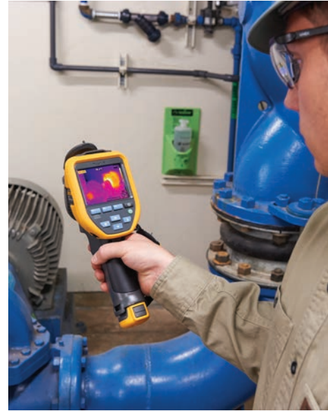
Un ingeniero utiliza una cámara termográfica Fluke TiS75 para inspeccionar un motor
